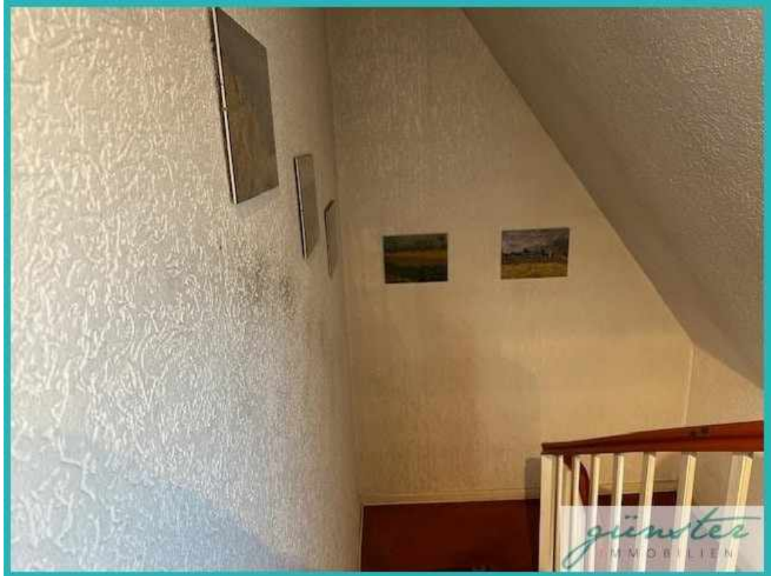
Treppenhaus zum Obergeschoss
